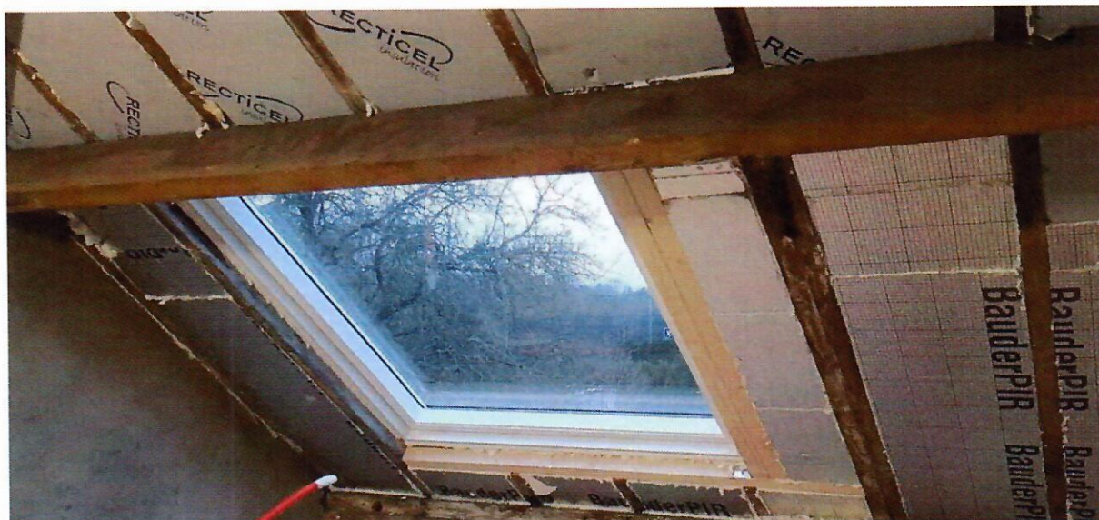
Plafond badkamer: PIR 2zijdig ALU 1200x600x60mm
