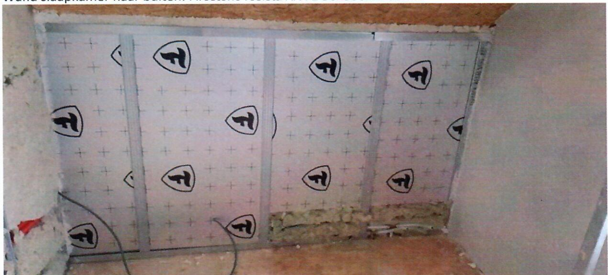
Wand slaapkamer naar buiten: Firestone resista AK-FL 30x600x1200mm
